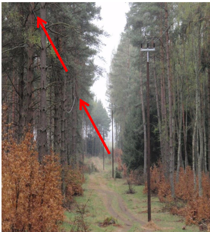
Комплекс сервисной воздушной линии СН, подвешенный на деревьях
